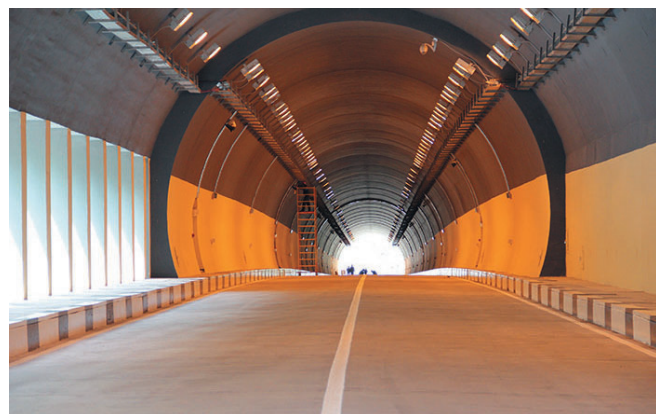
Рис. 9. Тоннель на автомобильной дороге «Алагир – Нижний Зарамаг»
