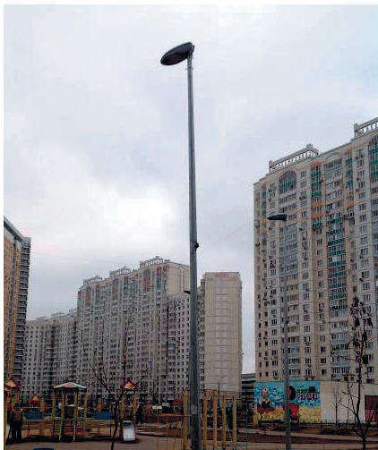
Рис. 20. Складывающаяся опора типа П-ФГ на детской площадке
