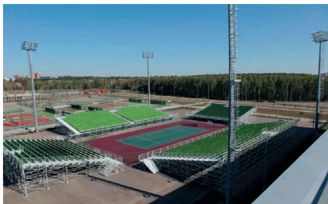
Рис. 8. Мачты «ОПОРА ИНЖИНИРИНГ» на объекте Академии тенниса в Казани
