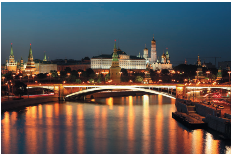
Рис. 12. Большой Каменный мост
